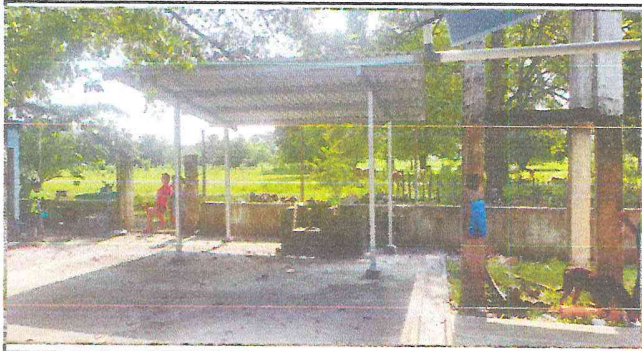
Foto 7: Estructura y techo de galera
